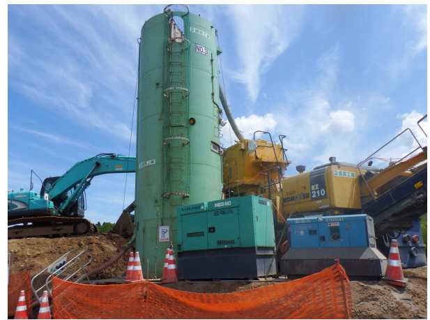
写真-4 リテラ工法のセメントプラント
