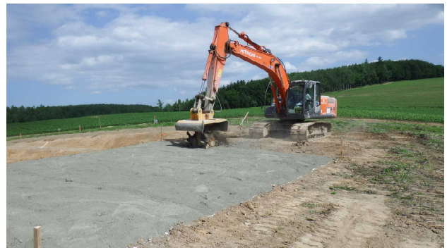
写真-2 ロータリースタビライザーによる攪拌
