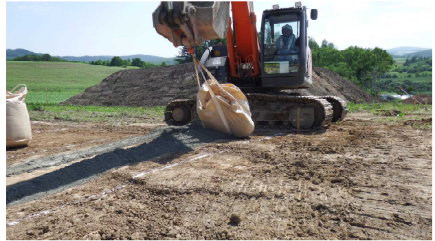
写真-1 セメント固化材敷均し
