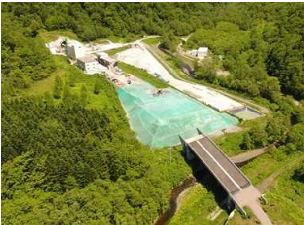
写真-3 音中トンネル起点
