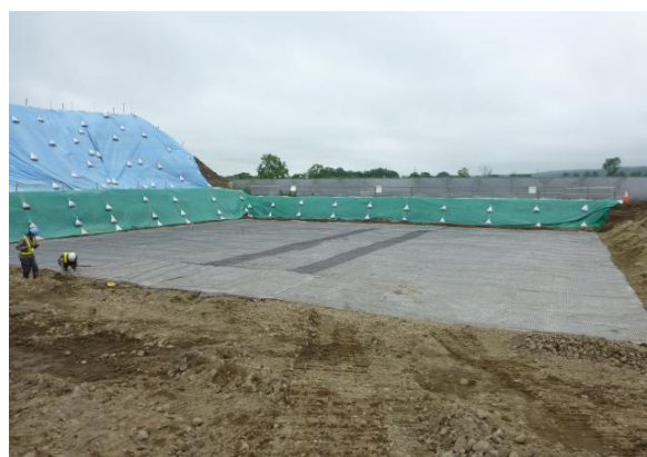
写真-2 カルバート基礎補強工の施工状況 (No. 2 ボックスカルバート)
