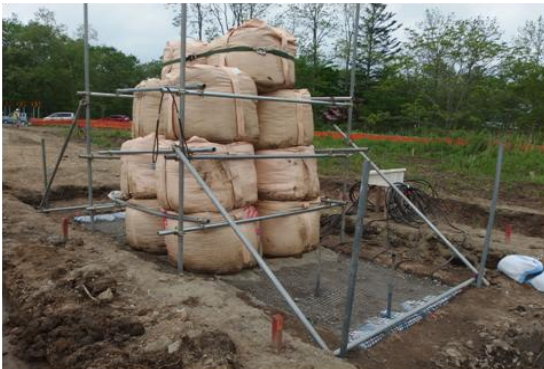
写真-1 フィールド試験状況写真
