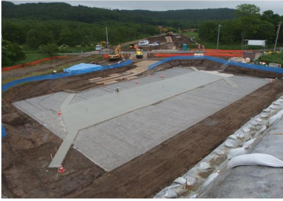
写真-3 カルバート基礎補強工の施工状況 (No.4 ボックスカルバート)
