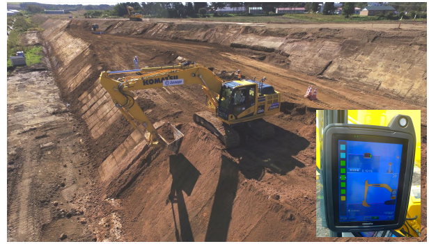
写真-1 法面整形状況およびモニター
