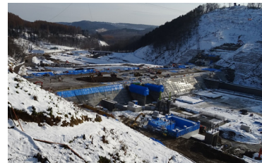
写真-1 現場状況(平成28年11月14日)
