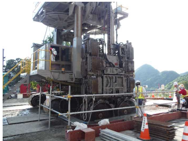
写真-2 岩盤掘削機での掘削状況
