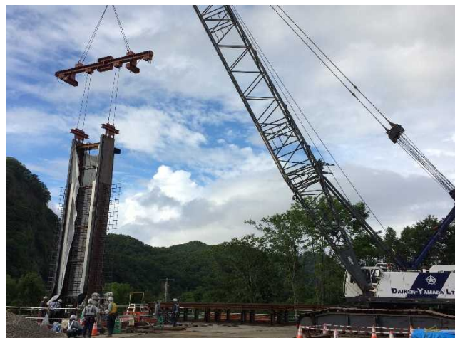
写真-3 鉄筋籠の建込み状況
