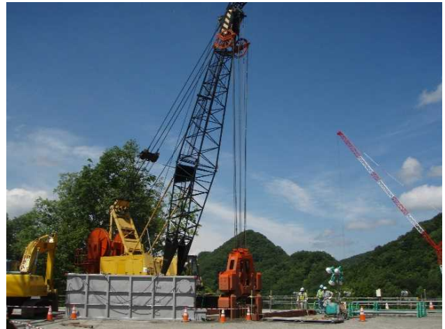
写真-1 バケット式掘削機での掘削状況
