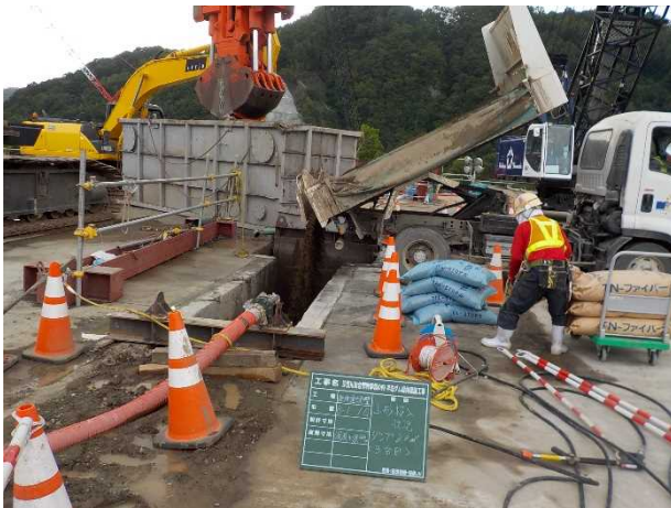
写真-4 山砂投入状況
