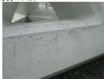
写真-11 基本ケースの外観
