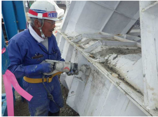
写真-2 壁バイブレータによる締固め
