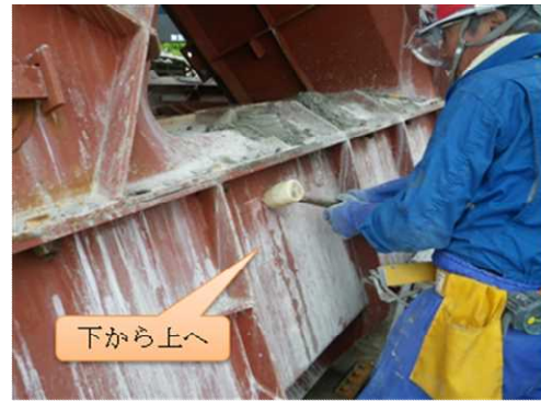
写真-4 型枠側面を木槌でたたき気泡を抜く方法
