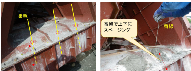
写真-3 空気抜孔3穴より番線を用いてスペーシングする方法
