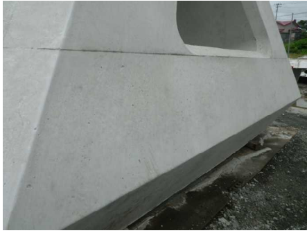
写真-12 ケース3-1の外観
