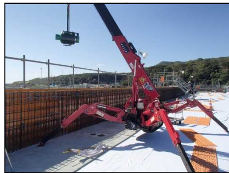
写真5 カニクレーンによる PC 緊張ジャッキ吊り上げ
