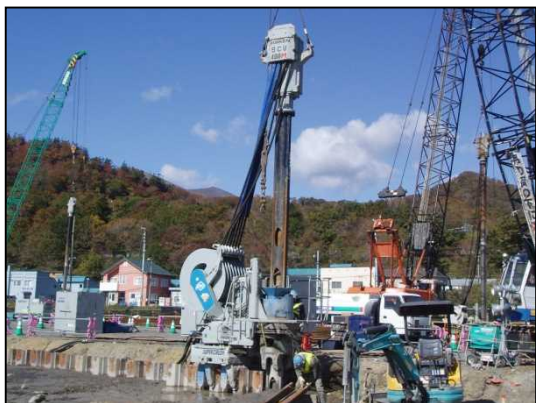
写真-6 鋼矢板打設状況（硬質地盤クリア工法）
