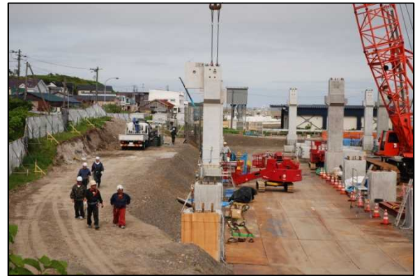
写真4 人工地盤背後における作業スペース確保状況
