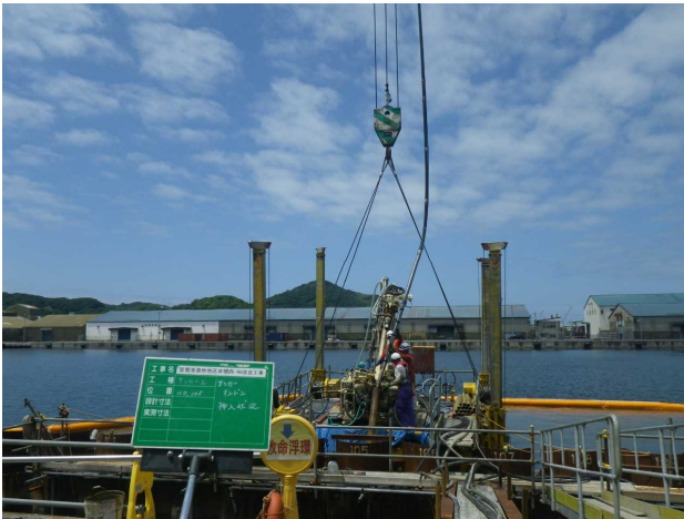
図-9 アンカー tendon 挿入状況
