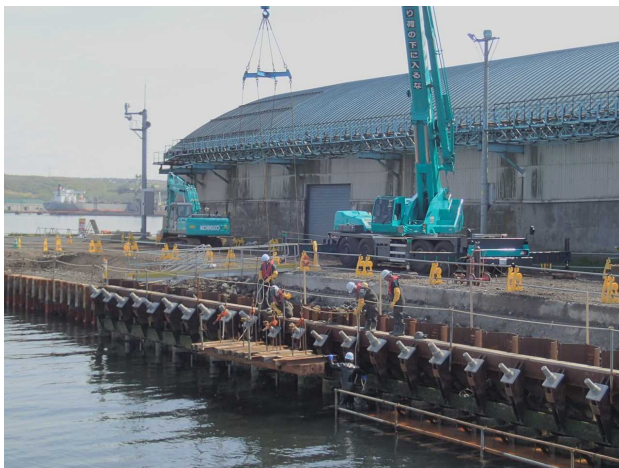
図-1 4 控えアンカー完成状況
