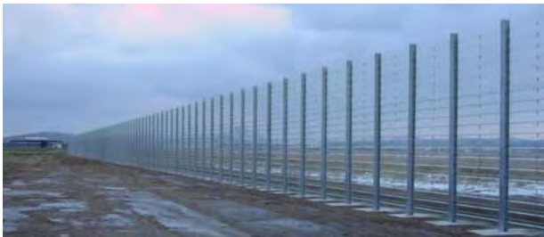
写真-3 試験防雪柵全景
