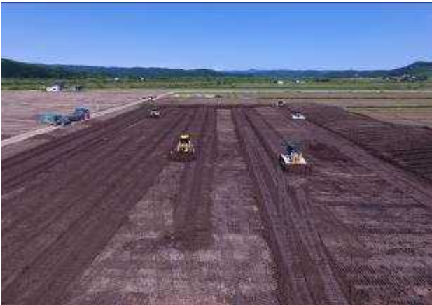
写真-2 整地工の作業風景（5月下旬～6月）
