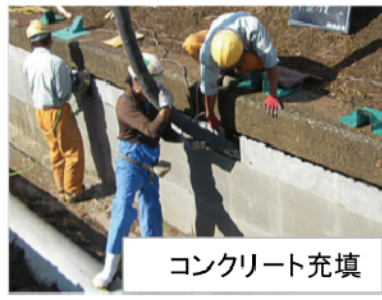
図-8 パネル系被覆工法の概要
