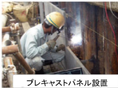
図-8 パネル系被覆工法の概要
