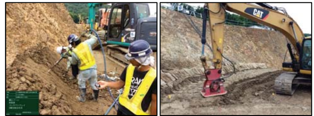
写真-4.6 エアタンパ締固め状況・中間材の転圧状況
