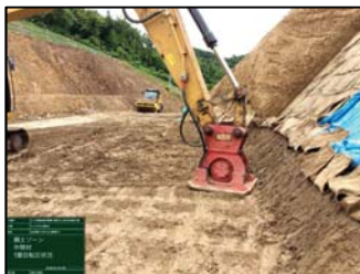
写真-4.3 油圧コンパクトを用いた中間材の転圧状況
