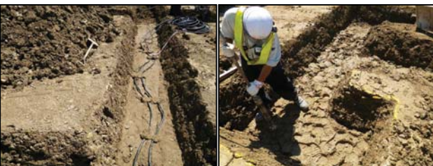
写真-4.11 溝内配線・コンタクトクレイ転圧状況
