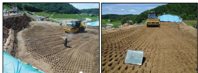
写真-4.8 鋼土・翰土のダム軸方向転圧状況
