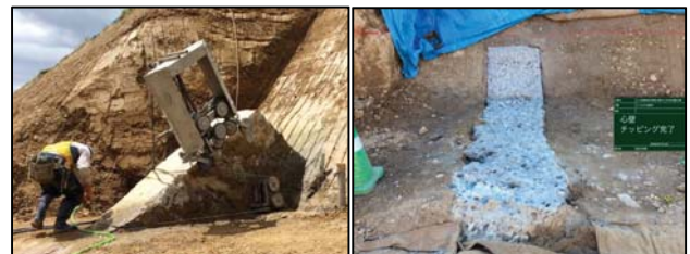
写真-4.1 心壁の切断状況・チップング処理状況
