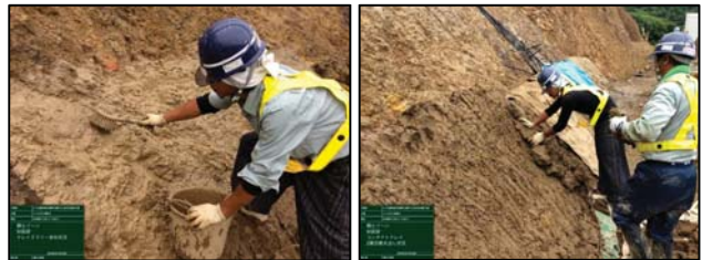
写真-4.5 クレイスラリーの塗布状況・コンタクトクレイ貼り付け状況
