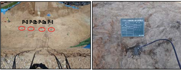
写真-4.9 基盤内の間隙水圧計 設置状況
