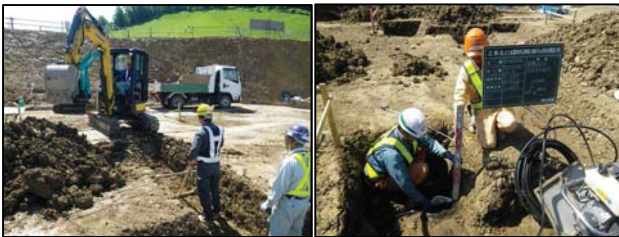
写真-4.10 配線用つぼ堀・水圧計設置状況
