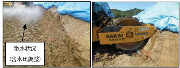
写真-4.4 既設堤体の搔起し・突起の貫入(だめ押し)状況
