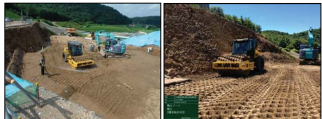
写真-4.7 鋼土・翰土の上下流方向転圧状況
