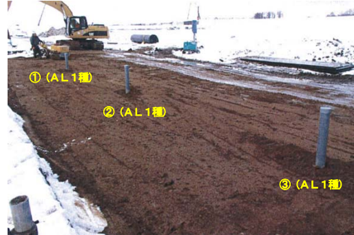
図-11 沈下測定管の設置状況
