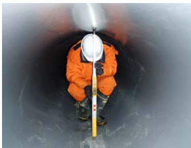
図-10 たわみ率の計測状況 (AL1種)
