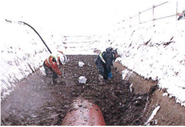
図-13 AL1種 管側部埋戻し状況
