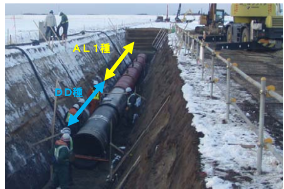
図-12 AL1種、DD種 管布設状況
