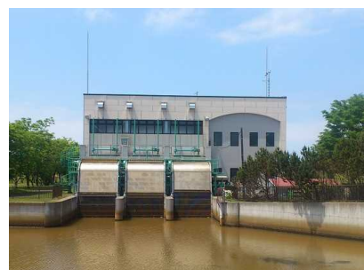
写真-2 斜里右岸排水機場の施設状況
