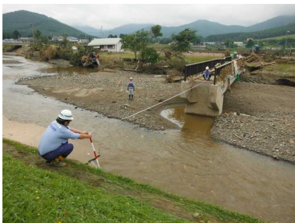
写真-5 橋梁の被災調査状況
