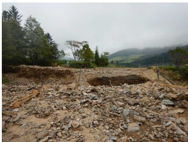
写真-7 串内地区の幹線道路被災状況
