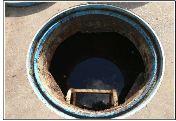
写真-1.3 北川口用水路保護工内 排水前
