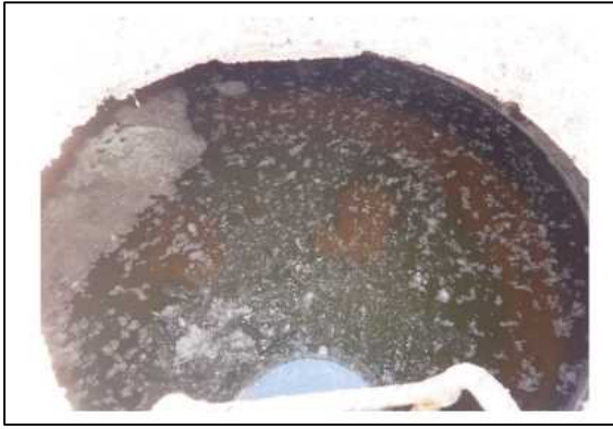
写真-1.1 天塩第1送水路保護工内 排水前
