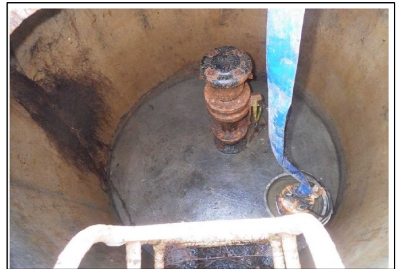
写真-1.4 北川口用水路保護工内 排水後
