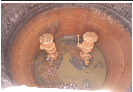
写真-1.2 天塩第1送水路保護工内 排水後
