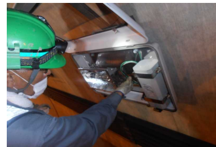
写真-2 点検状況（器具内部状況の確認）
