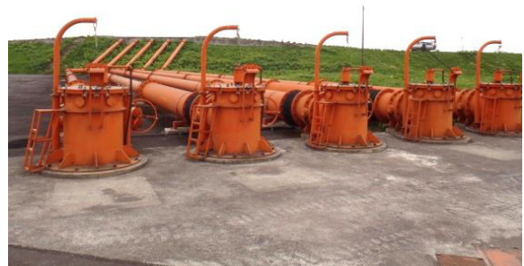
写真-1 救急排水機場外観
