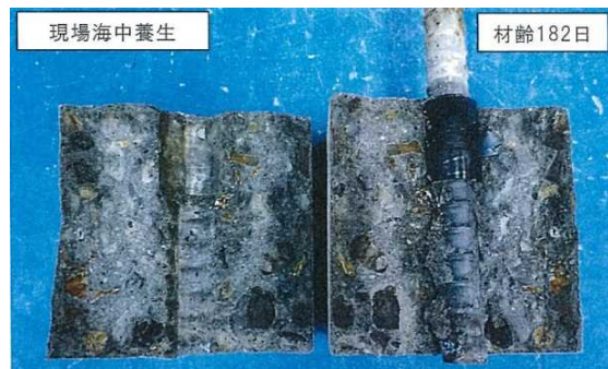
図5 鉄筋腐食状況
