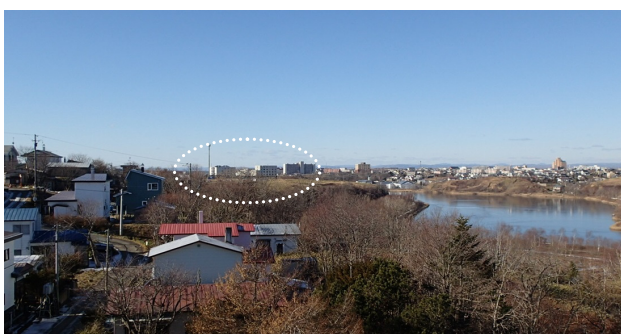
写真-9 周囲からの見え方 (B棟外壁改修後) 1
