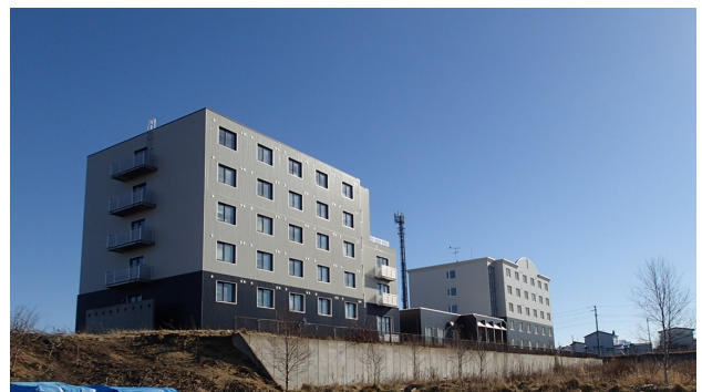
写真4 [B棟] 外壁改修時 (左)
