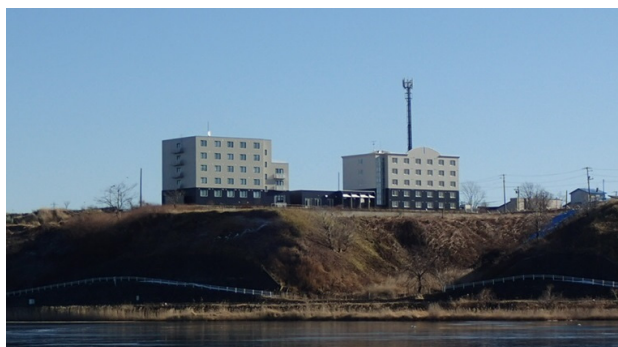
写真-10 周囲からの見え方 (B棟外壁改修後) 2
