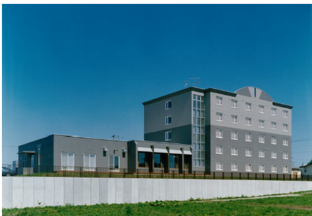
写真-1 [A棟] 新築時
