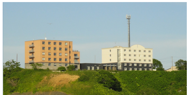
写真3 [A棟] 外壁改修時 (右)
