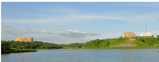
写真-8 (左) 釧路市博物館 (右) 外壁改修前の当部建物
