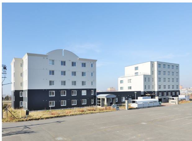
写真-11 周囲からの見え方 (B棟外壁改修後) 3
