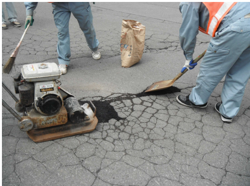
写真5 作業手順4 (転圧)
