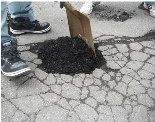
写真4 作業手順3 (敷き均し)
