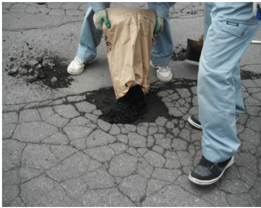
写真3 作業手順2 (投入)
