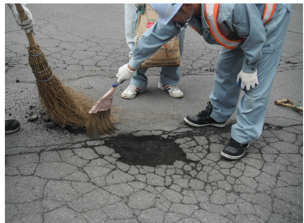
写真-2 作業手順-1（清掃）
