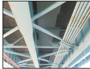
写真-7 表面被覆状況
