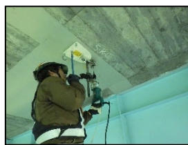
写真16 穿孔作業状況
