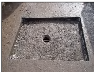
写真-5 舗装開削後
