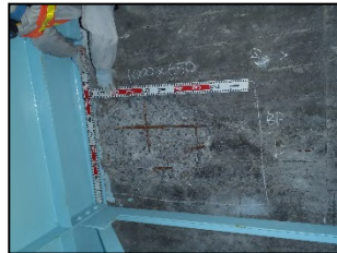
写真-4 浮き除去後
