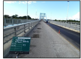
写真-8 舗装撤去後
