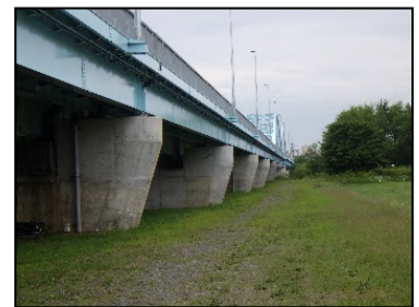
写真-2 深川橋側面
