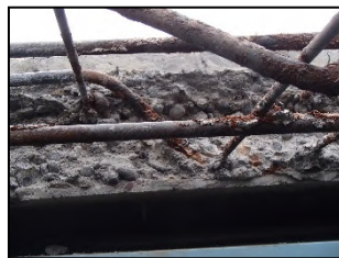
写真-6 はつり状況
