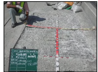
写真-10 土砂化部切削後
