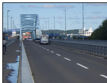
写真-1 深川橋橋面
