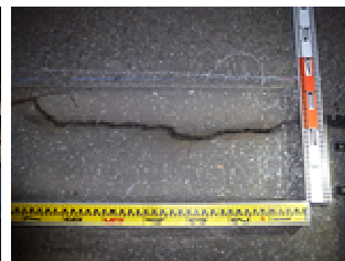
写真-9 特殊切削方法による切削面
