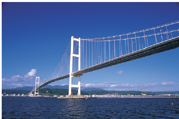
写真-1 白鳥大橋全景
