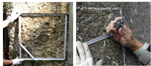
写真-2 剥離度調査状況 写真-3 剥離深さ測定状況
