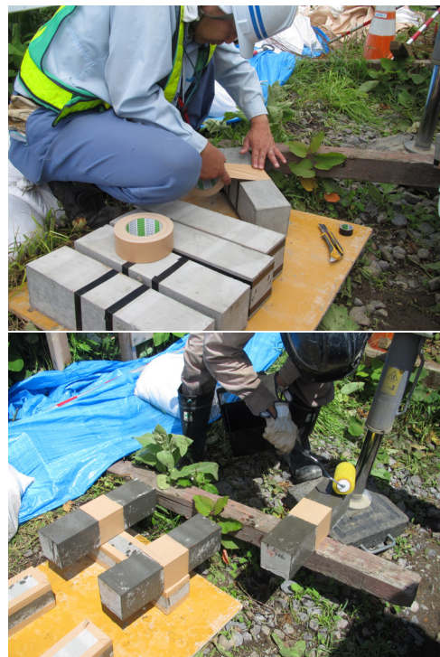
写真-2 テープ貼りおよび塗布状況（ケース1）
