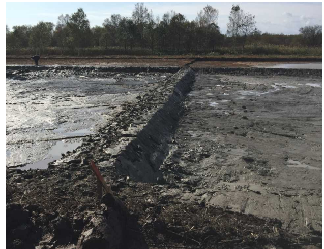
図-16 試験地造成状況（遮水用の粘性土敷設）
