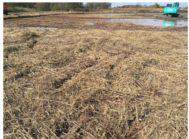
図-17 試験地造成状況（ヤナギ抜開、除根なし）
