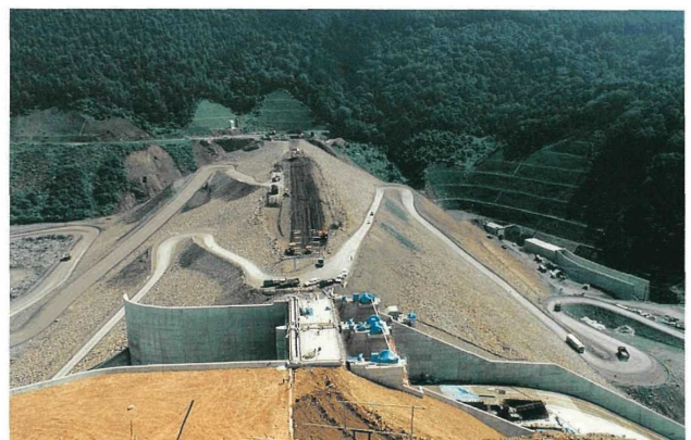
写真-3 上下流面取付道路状況
