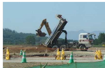
写真-2 工事実施状況(平成26年6月)
