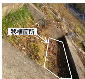
写真-2 移植法枠の状況
