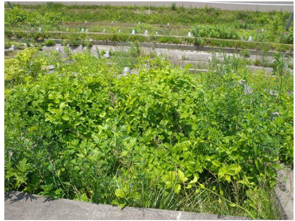
写真-9 対象法面の完成7年後 (平成27年7月23日撮影)
