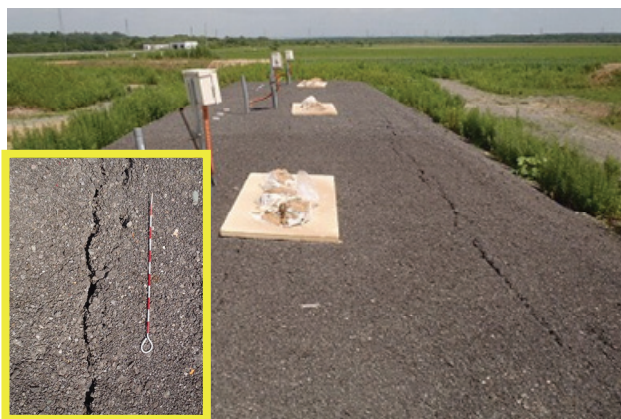
写真-2 盛土の天端の状況
