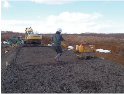
写真-1 転圧状況
