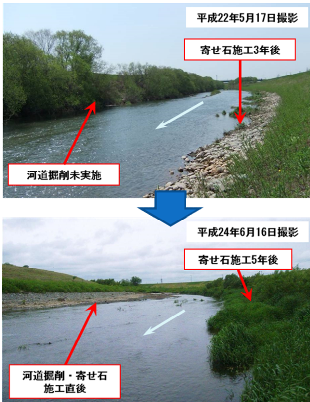
写真2 KP0.5地点の寄せ石施工箇所
