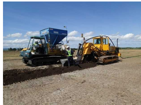
写真-3 暗渠排水工
