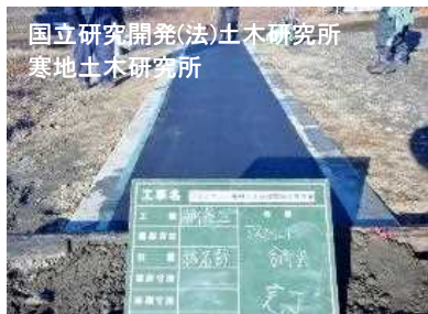
フィールド試験：平成27年12月～【検証中】 北海道苫小牧施工試験フィールド内・寒地試験道路
