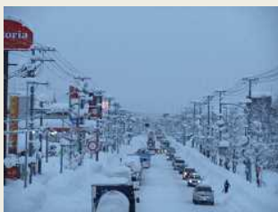
電柱への積雪で高まる断線リスク
