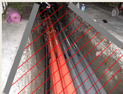
無電柱化における地中埋設埋め戻し後の目地箇所に
