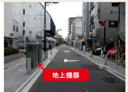
無電柱化の際に設置する地上機器と舗装の継ぎ目箇所に
