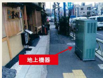
無電柱化の際に設置する地上機器と舗装の継ぎ目箇所に
