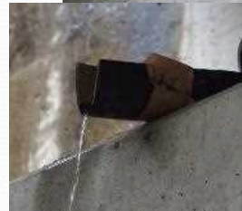
排水装置本体設置後、排水管設置までの間に降った雨水を排水する様子
