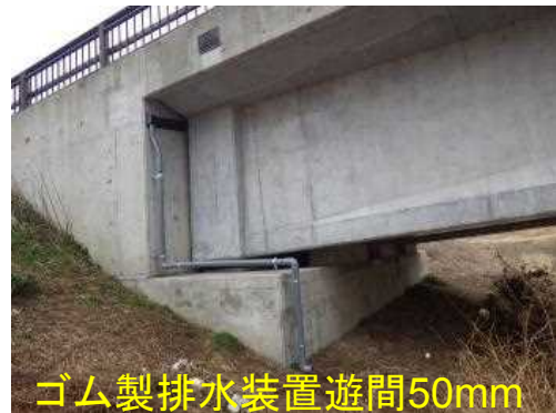
ゴム製排水装置遊間70mm
