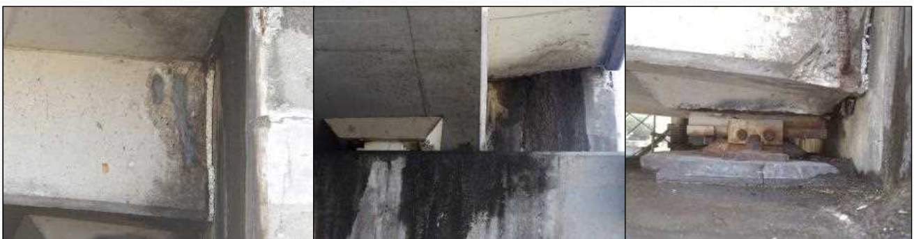
主桁の損傷
