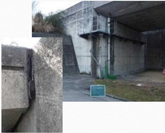
ゴム製排水装置遊間50mm
