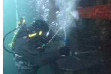
③ レール部取付 (樹脂アンカー取付+ボルト締め)
