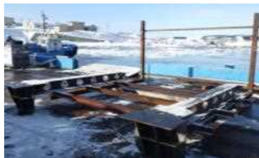
① 架台にレールを設置
