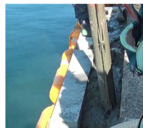
⑩ コンクリート打設
