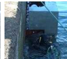
⑨ 漏れ防止板設置
