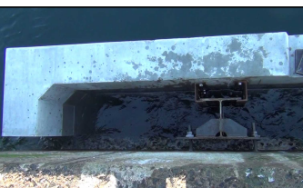
⑧ パネル設置 (レールにパ° 初のチャコルを入れる)
