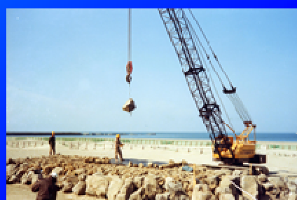
捨石落下状況
