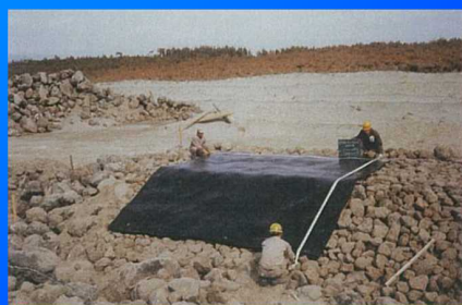
アスファルトマット敷設
