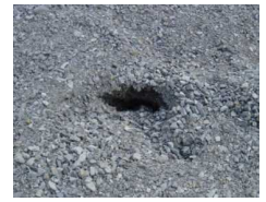
土砂の流出による空洞
