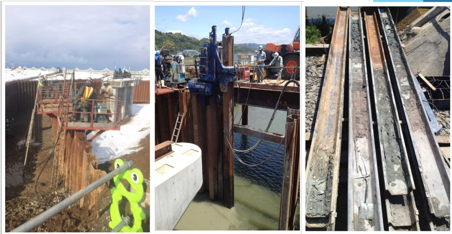
国交省 橋脚建設工事（高知）
