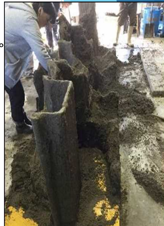
【鋼矢板を引き抜いた翌日に掘り出して現れた土中の充填材の矢板】
