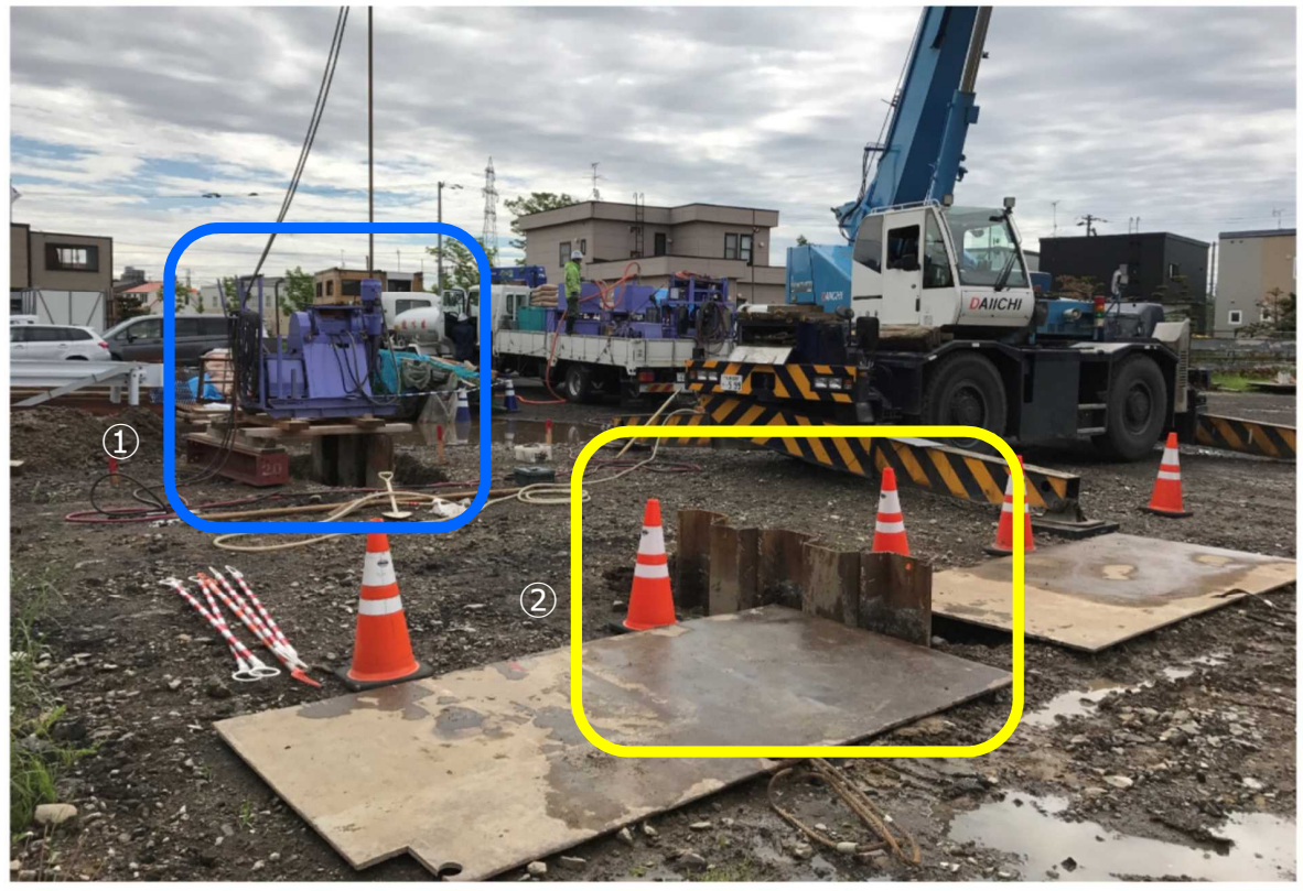
土留部材引抜同時充填工法研究会
