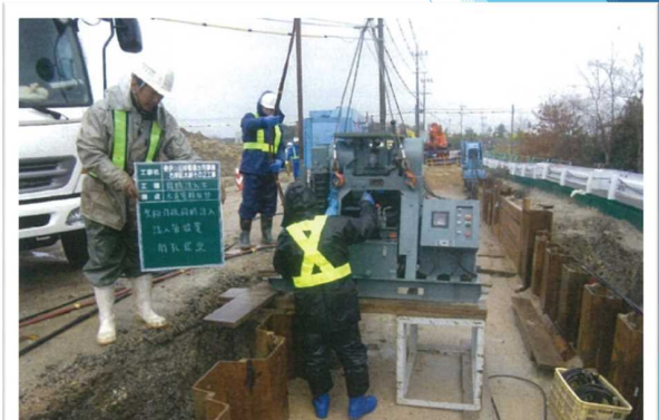
YT-3工法(充填管を固定しない方式)
