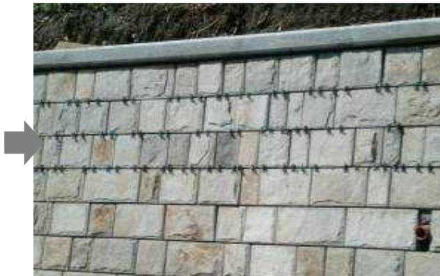
コンクリート面に薄い石を貼っている工事
