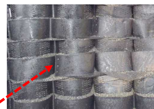
補修箇所の切断なし
