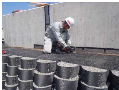
(5) ジオネット敷設
