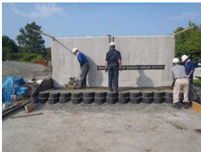
(4) 中詰材投入・転圧 (上段)
