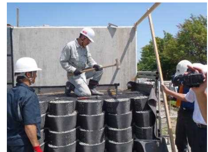
(6) 鉄筋アンカーの打設
