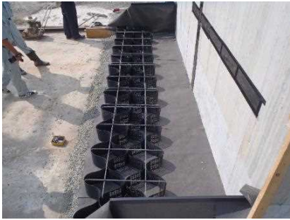
(1) ジオセルの設置 (下段)
