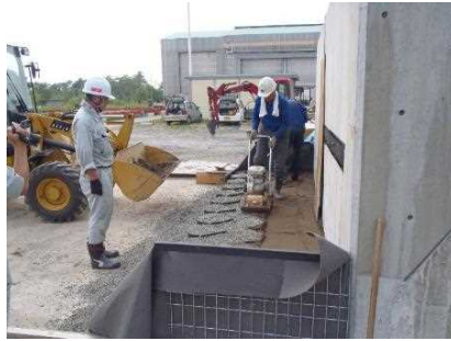
(2) 中詰材投入・転圧 (下段)
