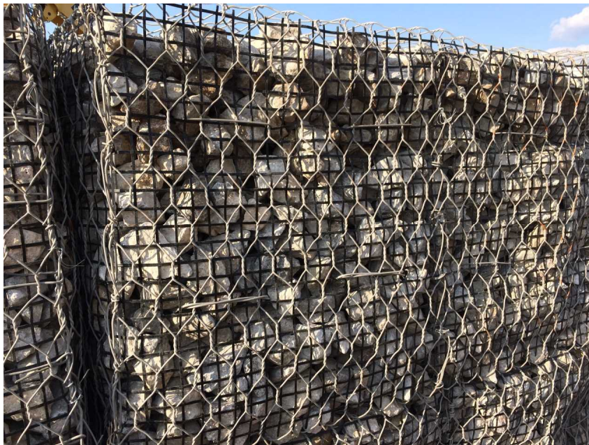
内張ネット配置状況
