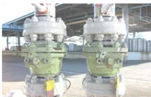
解放検査部のみ防錆 (塗装に比較しケレン処理 不要で採用)
