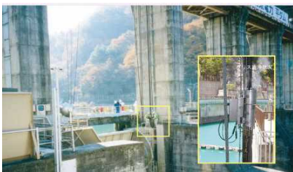
ゲートワイヤーロープ整備風景
