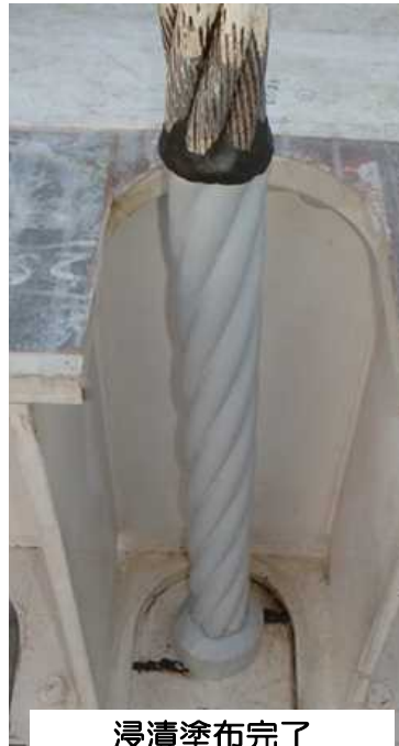
実橋外面被覆状況 (上部写真：駆動調整器)
