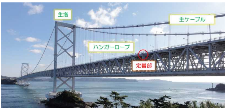
大鳴門橋（1985年竣工：33年目）
