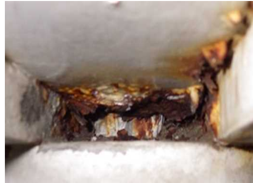
支圧板内部状況
