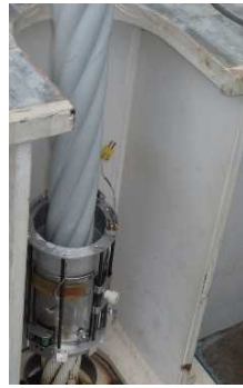
実橋外面被覆状況 (上部写真：駆動調整器)
