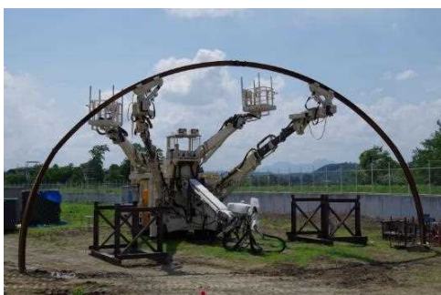
試験状況 (前方より)
