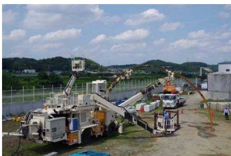
試験状況 (後方より)
