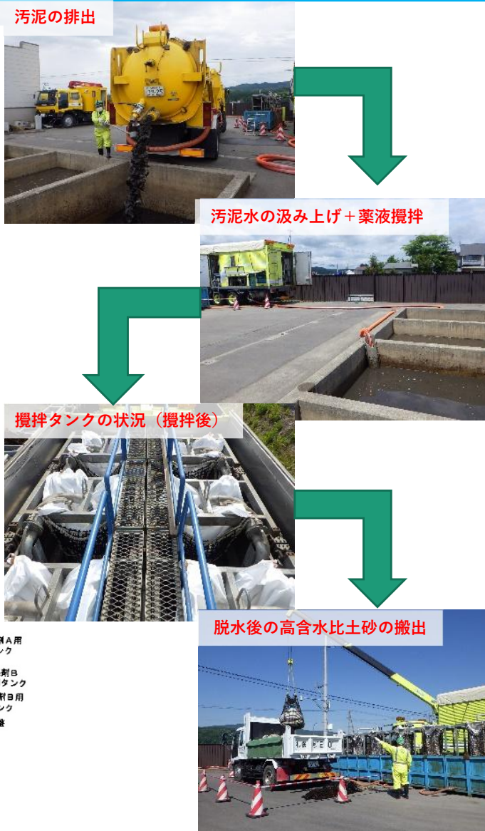
図1 汚泥処理車の作業フロー（寒地論文からの抜粋）
