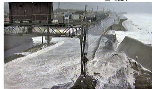
至 岩内町 国道229号 越波状況
