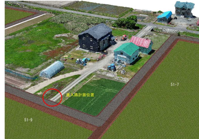
写真測量で現況田面高を可視化することによる設計作業の効率化
