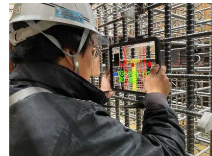
配筋検査ARシステムの配筋検査状況
