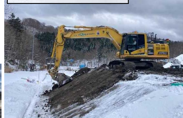
ICT施工（MC建機）
