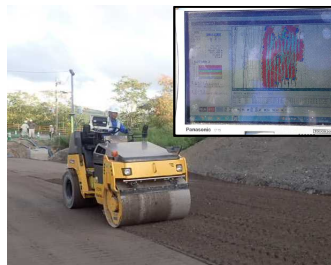
GNSSを用いた盛土締固め管理
