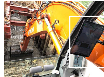
3Dガイダンスシステム装着状況 (白枠：情報表示タブレット)
