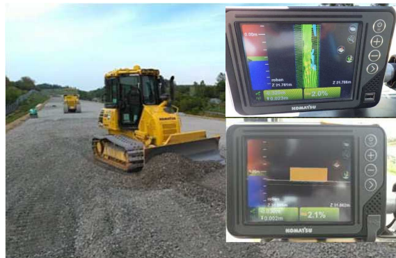
【マシンコントロールブルドーザ】
