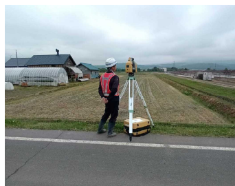
TLSを用いた3次元起工測量
