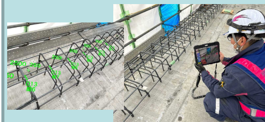
AR技術による配筋検査
