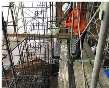
AI配筋検査端末 (左：配筋撮影状況 右：端末画面)
