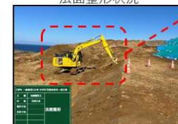
法面整形状況
