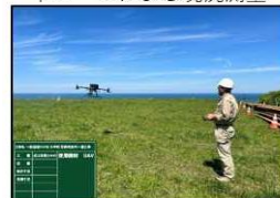
ドローンによる現況測量
