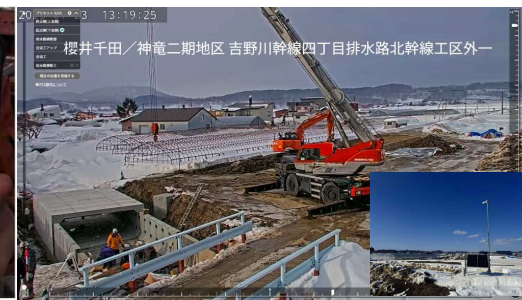
ソーラーパネル式Webカメラ（右下）と現場事務所内モニター表示画面
