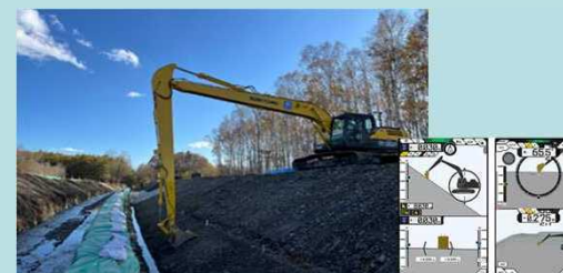
MG搭載バックホウによる掘削状況
