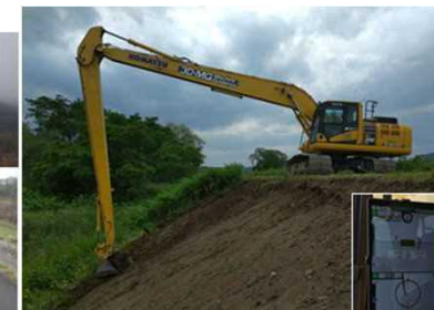
MCバックホウによる掘削
