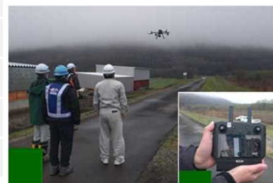
UAVによる起工測量
