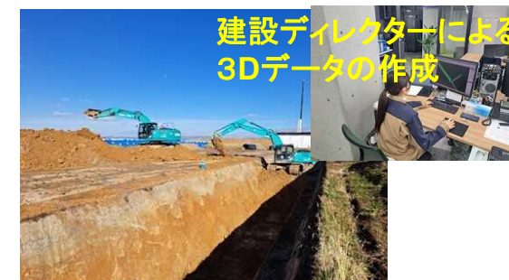
MCバックホウによる掘削状況
