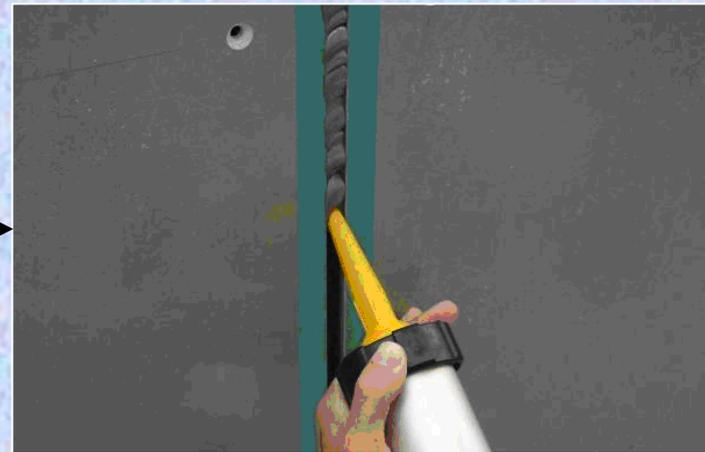
専用ガンによる目地材の充填
