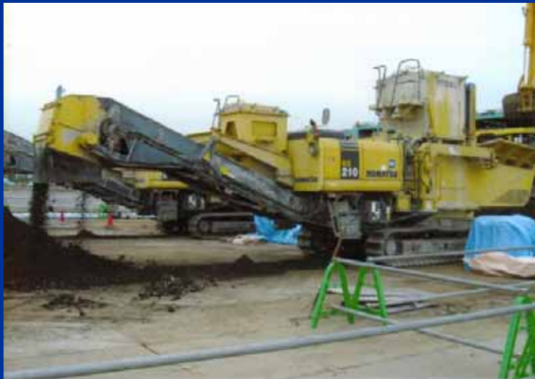
現場不溶化処理作業
