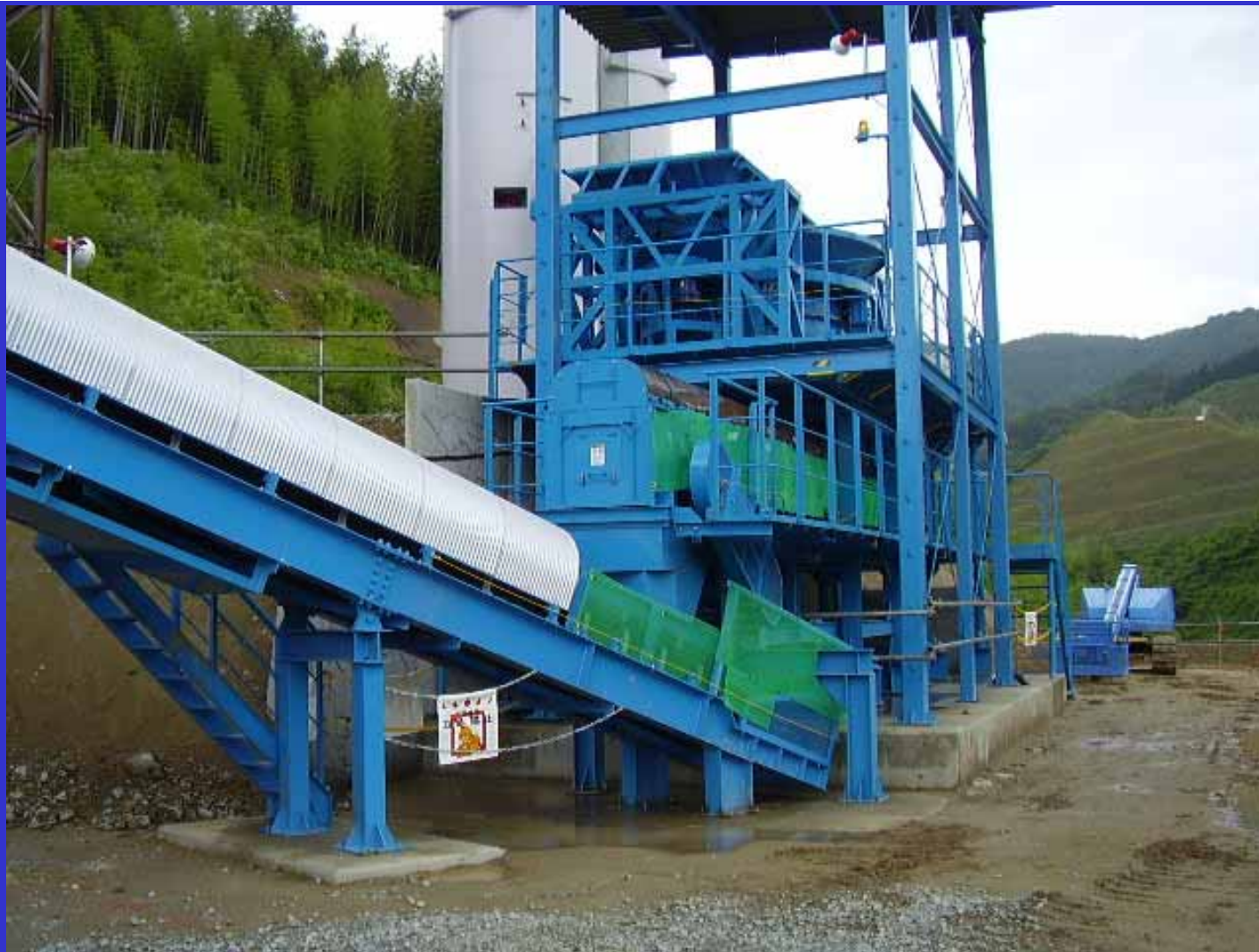
国土交通省 中国地方整備局 尾原ダム工事現場
